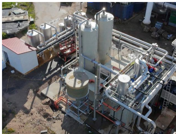
Kuva 3.1 Modulaarisen kaatopaikkakaasun epäpuhtauksien puhdistusjärjestelmän prototyyppi. Puhdistusjärjestelmä hyödyntää kaatopaikka-alueen olemassa olevaa infrastruktuuria, sähkö-, viemäri- ja vesijohtoverkkoa. Kuvan lähde: Zemite et al., 2025a.
