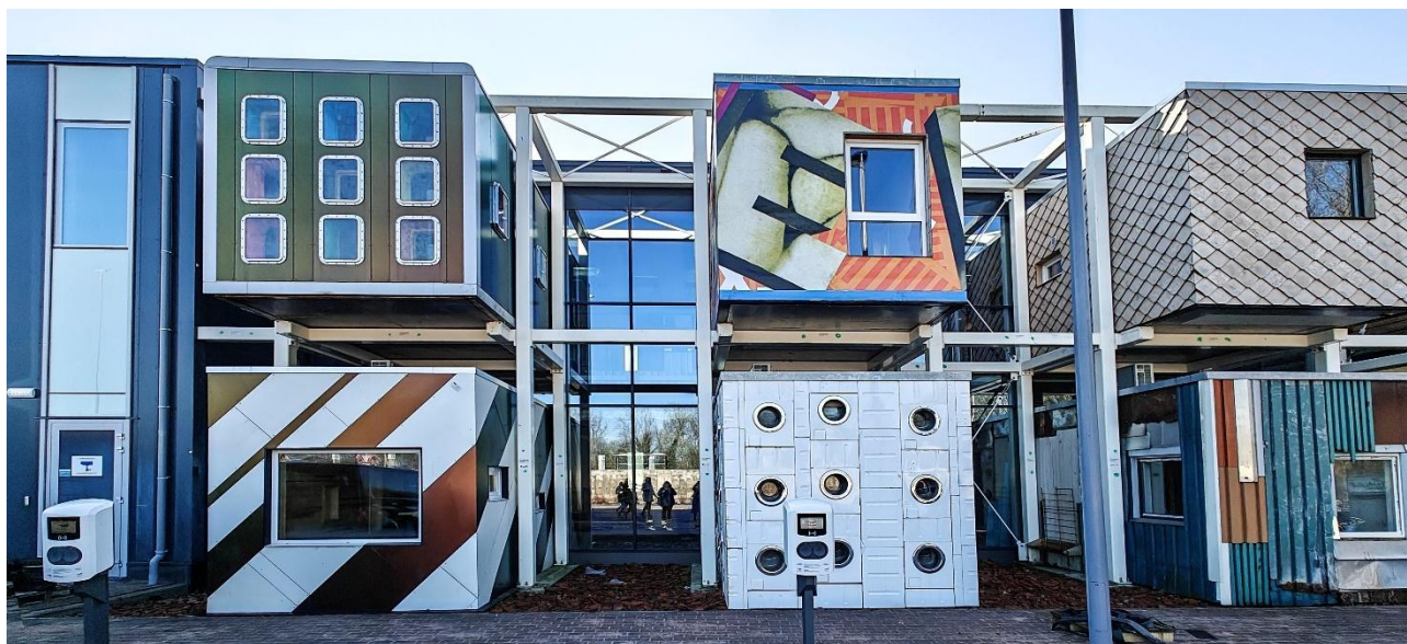
De HERin julkisivussa näkyvät yksilöllisiksi suunnitellut Boksit, eli kontit, joita vuokrataan toimistotiloiksi.
